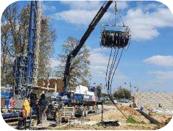
Mise en œuvre de sondes géothermiques
