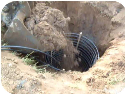
Mise en œuvre d'une corbeille
