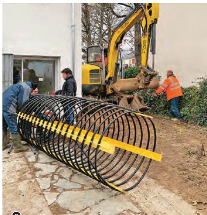
PHOTO 2 / Chantier géothermique chez un particulier. © XAVIER MOCH, AFG
