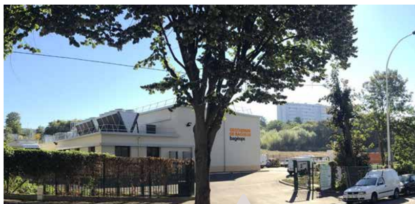
Inauguration de la centrale géothermique de Bagneux le 11 octobre 2016 (DALKIA)
