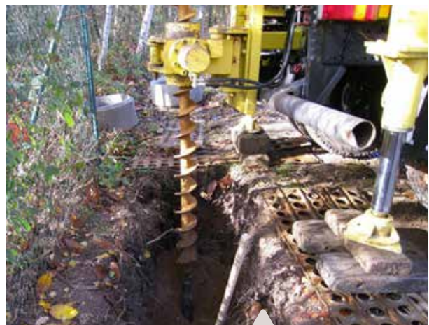
Forage avec une tarière sur le site du BRGM (Orléans)
